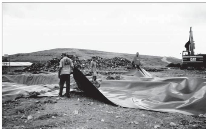
Figura 4.19 Lâmina de PEAD 2 mm sendo puxada para cobrir a célula.
