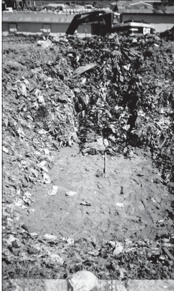
**Figura 4.16** Lixo sendo recolocado na vala da célula C6 – detalhe do dreno de percolato no fundo da célula.
