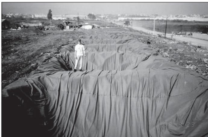
Figura 4.18 BIDIM 400 sobre a célula C6.
