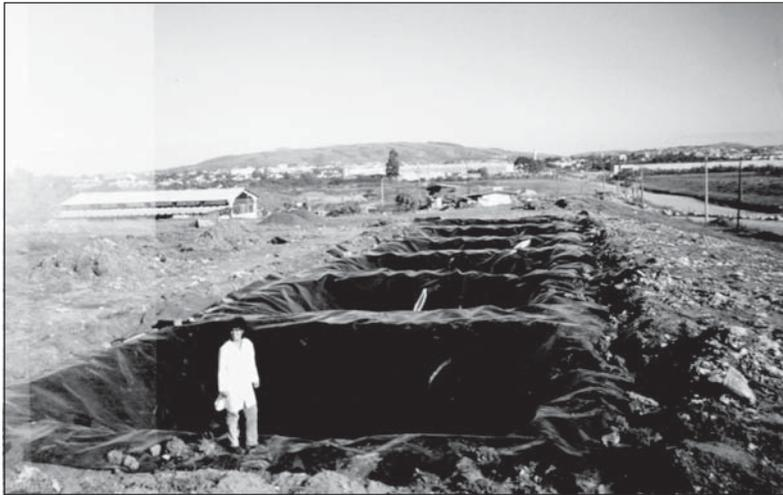
Figura 4.21 Vista do conjunto das células C1 a C6, recobertas por PEAD 2 mm.
