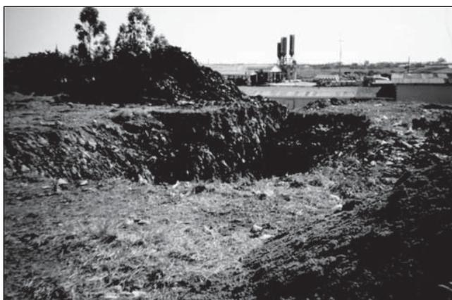
Figura 4.13 Lixo retirado da vala da célula C6, para ser recolocado após a instalação do dreno.
