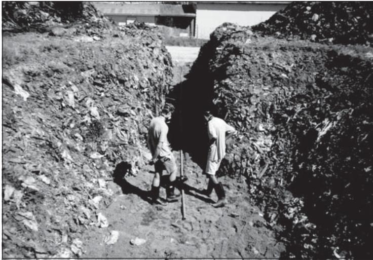
**Figura 4.15** Detalhe do dreno de percolado da célula C6.
