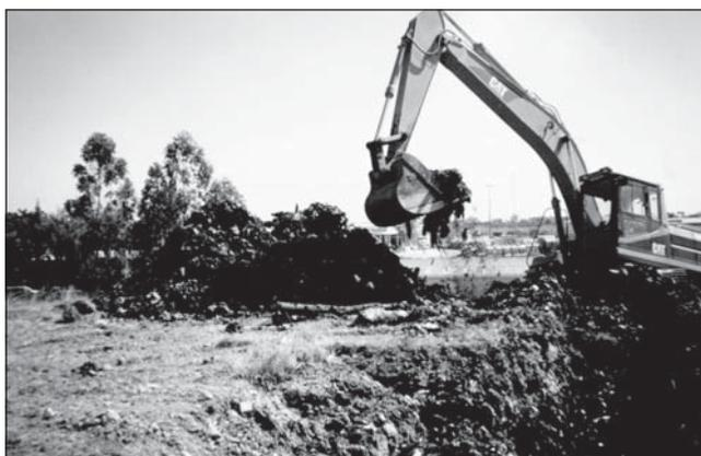
Figura 4.12 Finalização da escavação da célula C6 e início da escavação da vala.
