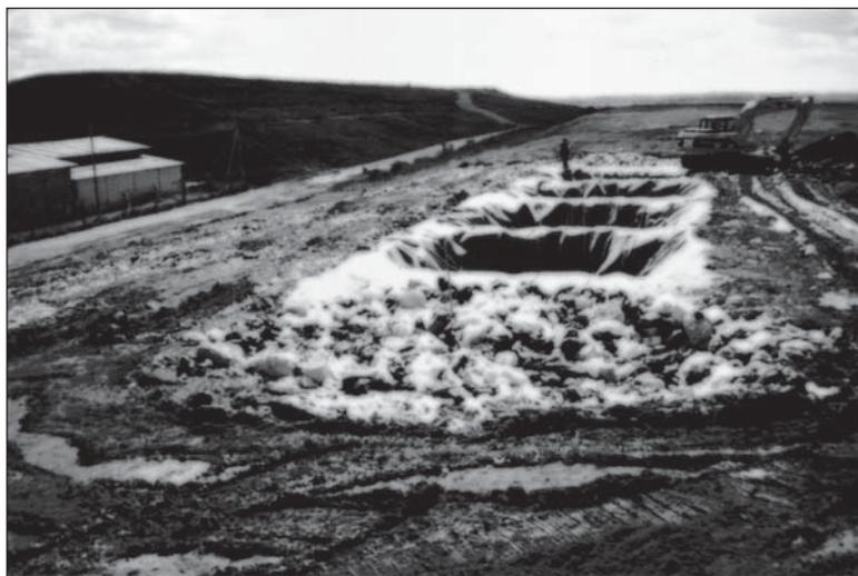
**Figura 4.24** Vista das células C6 (inferiormente na figura) e C1, contendo, respectivamente, RSSS e RSU (C18).
