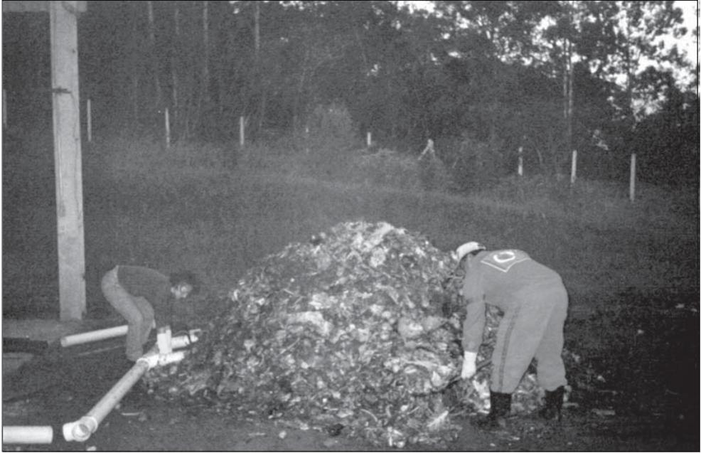
Figura 3.40 Montagem da leira estática aerada mecanicamente.
