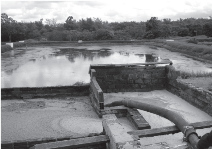
Figura 6.4 Tratamento de lodo de fossa séptica (empresa Potiguar)
