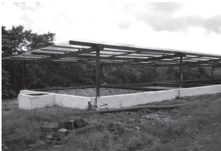
Figura 6.5 Leitos de secagem (empresa Potiguar)
