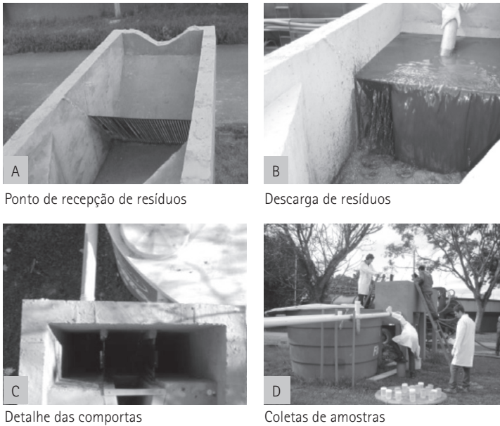
Figura 3.1 Vistas do amostrador utilizado para receber os resíduos esgotados pelos caminhões limpa-fossa na ETE Belém (Sanepar)
