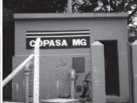
Figura 1.14 Casa de máquinas da estação elevatória Vista Verde
