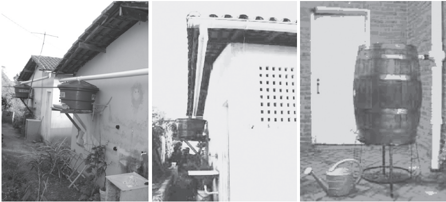
Figura 5.2 Sistemas simples de aproveitamento de água de chuva em habitações populares
