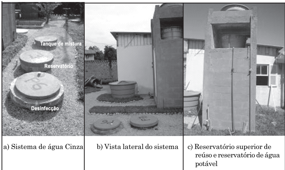
Figura 4.31 Sistema de reúso de água cinza.
