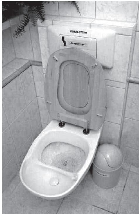
Figura 6.15 Vaso sanitário segregador de urina
